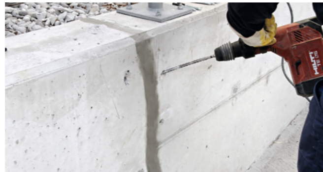
Bauteil schräg zum Rissverlauf abwechselnd links und rechts anbohren, wobei das Bohrloch den Riss etwa in der Mitte überschneidet
