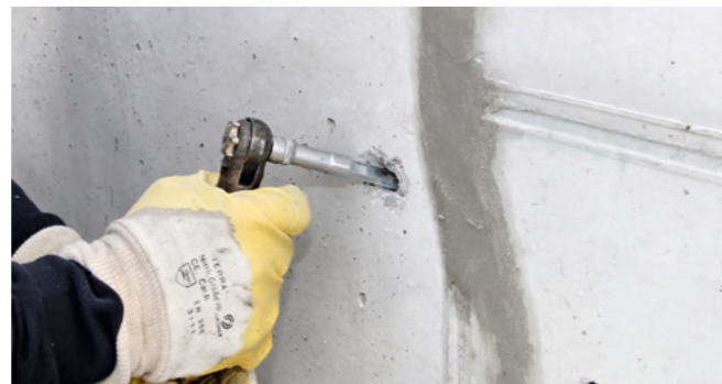
Bohrloch reinigen und PCI Apogel Tagespacker fest eindrehen
