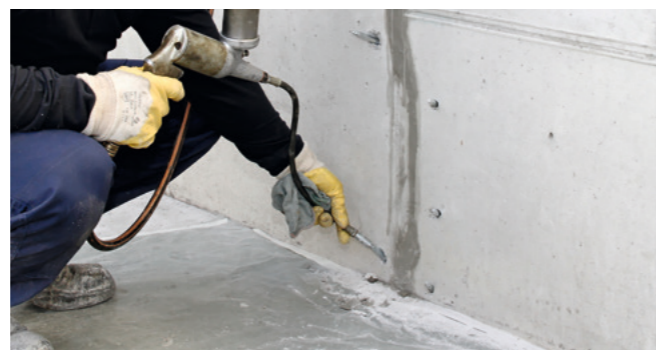
Injektionsharz, beginnend mit dem untersten Bohrloch, bis zur vollständigen Sättigung injizieren
