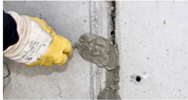
Risse mit Mörtel schließen
