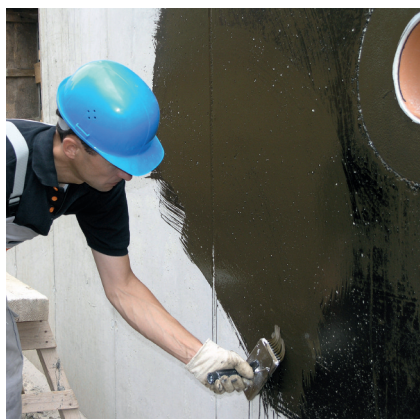
Grundierung im Sommer: PCI BT 26, Grundierung im Winter: PCI BT 28 Spezial- grundierung
