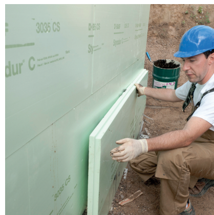
Fixieren von Dämmplatten mit PCI Pecimor® DK
