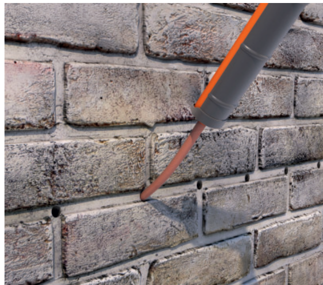
2. PCI Barra® Creme von Innen nach außen injizieren
