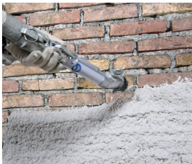
Einlagiger Auftrag des PCI Saniment® 2 in 1 auf eine Kellerinnenwand
