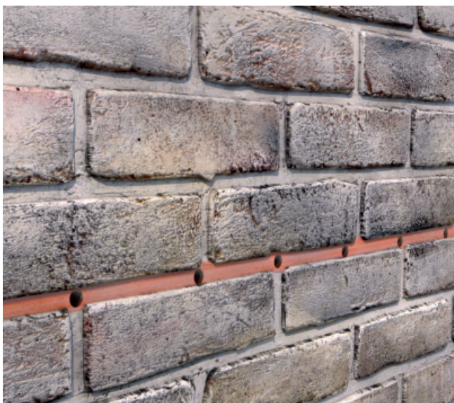
3. Ausgebildete Horizontalsperre aus PCI Barra® Creme
