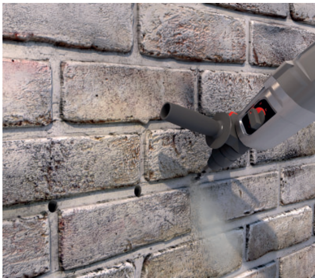
1. Bohren und anschließend Bohrloch ausblasen
