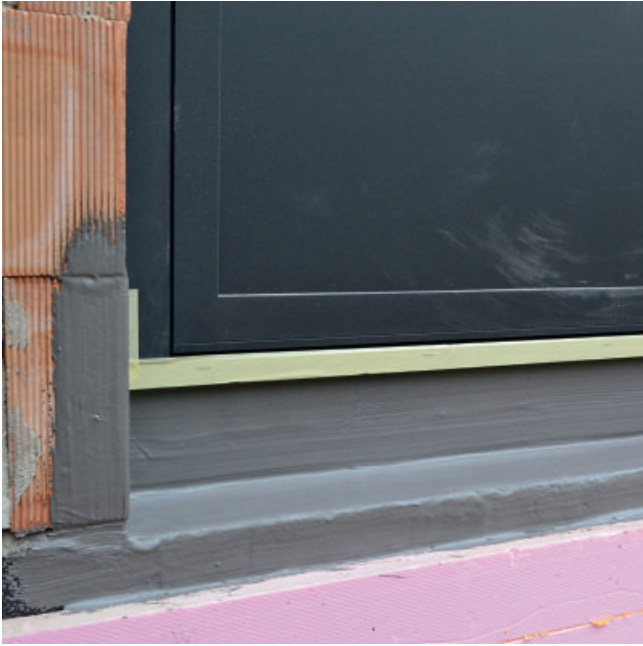
Anschluss an bodentiefe Fensterelemente mit PCI Barraseal® Turbo
