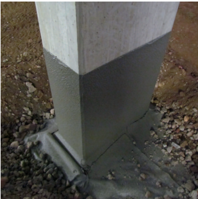
Oberflächenschutz von Betonbauteilen nach OS 5b mit PCI Barraseal® Turbo
