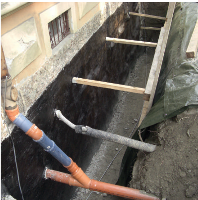
Reaktivabdichtung PCI Barraseal® Turbo auf Altabdichtungen
