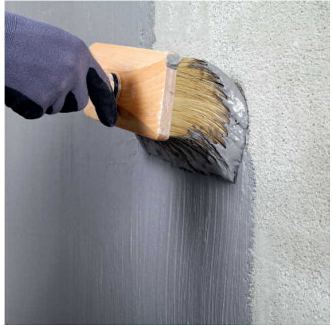
Anwendung als Flächenabdichtung PCI Barraseal® Turbo
