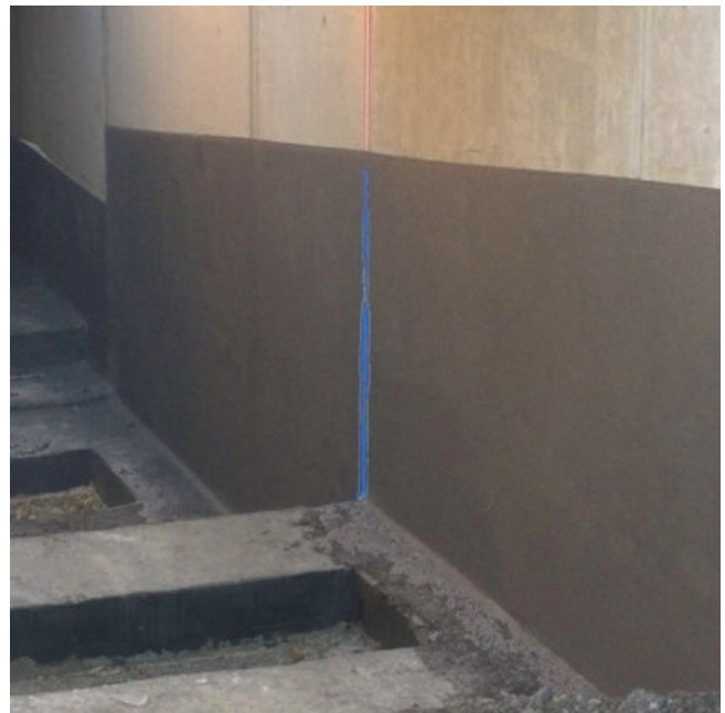
Anwendung als Flächenabdichtung PCI Barraseal® Turbo
