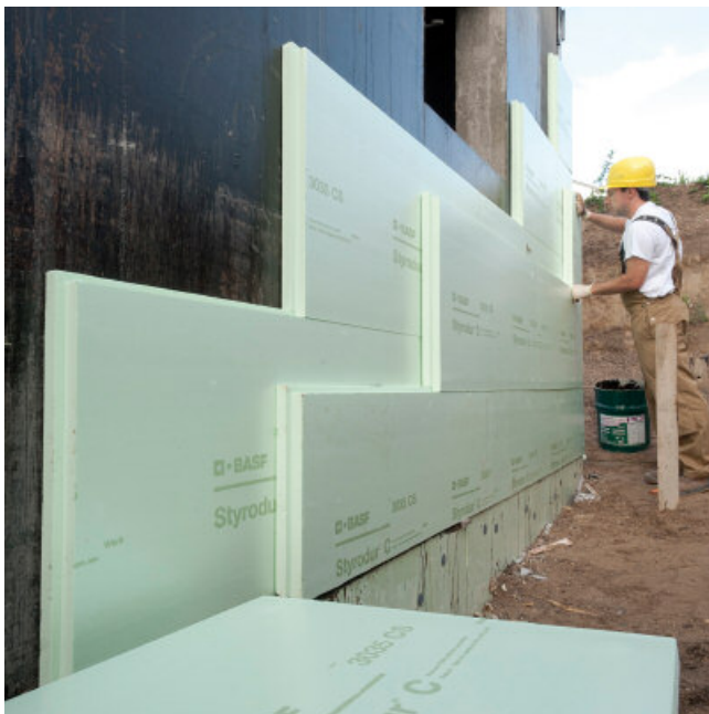
Fixieren von Dämmplatten mit PCI Pecimor® 2K oder dem Dämmplattenkleber PCI Pecimor® DK
