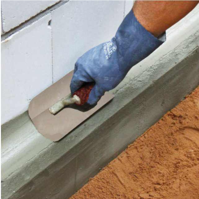
Hohlkehle aus wasserdichten Mörtel z.B. PCI Polyfix® plus L
