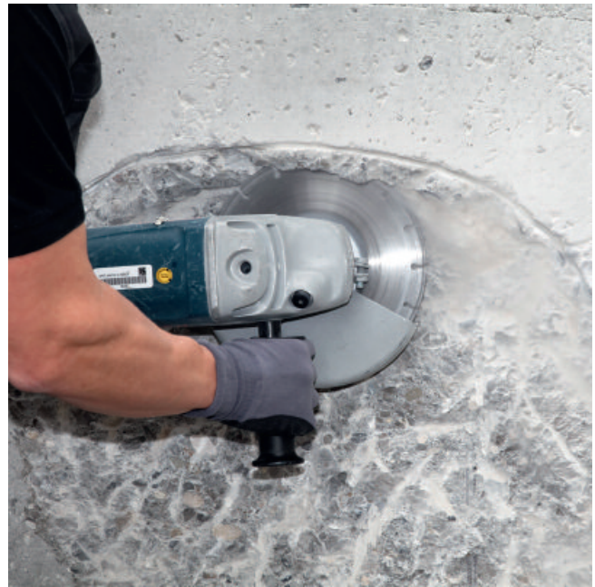
Ein sauberes Ausschneiden der Kanten schafft einen sauberen Übergang und eine optimale Anbindung des Reparaturmörtels.
