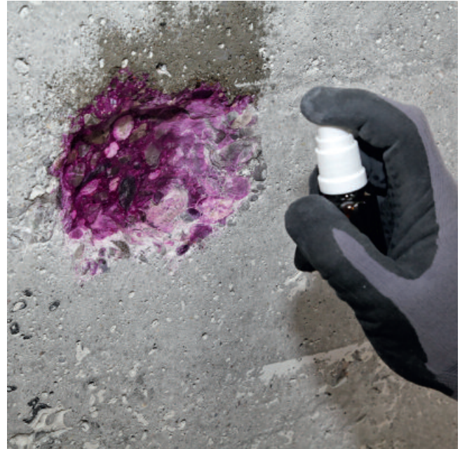
Hier bietet der Beton ausreichenden Schutz. Die violette Farbe zeigt, dass der Beton ausreichend alkalisch ist.
