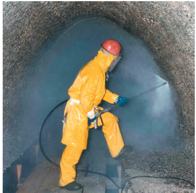
Das Größtkorn soll kuppenartig freiliegen aber noch fest in der Betonmatrix verankert sein.
