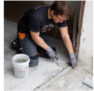
Alternativ mit Mörtel ausspachteln
