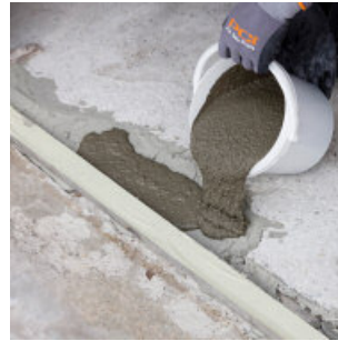
Einfahrtsschiene mit fließfähigem Mörtel hintergießen
