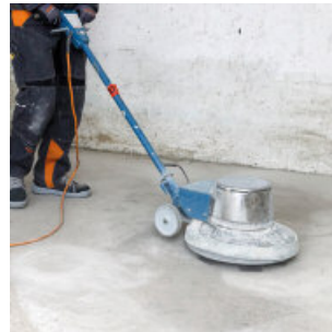
Boden abschleifen
